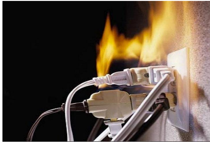
Hình 1.12: Sự cố quá tải
