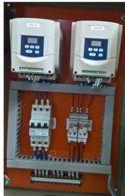
Hình 5.4: Bàn phím cài đặt của một loại biến tần 1 pha.
