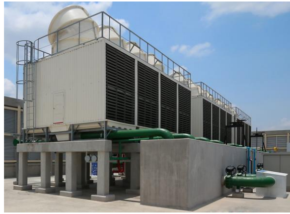
Hình 6.1: Tháp giải nhiệt (Cooling Tower).
