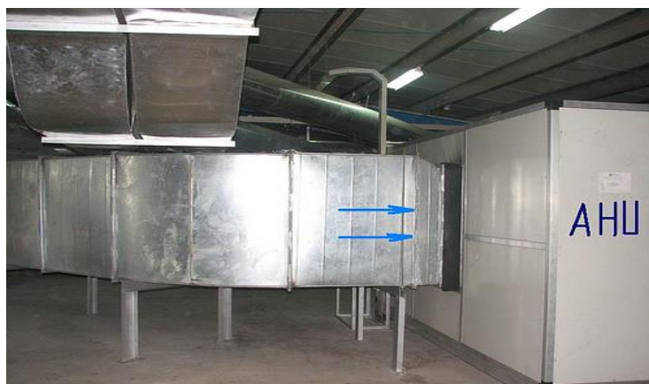
Hình 4.7: AHU – Air Handling Unit.
