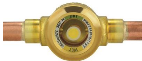
Hình 4.1: Mắt xem gas hệ thống lạnh.
