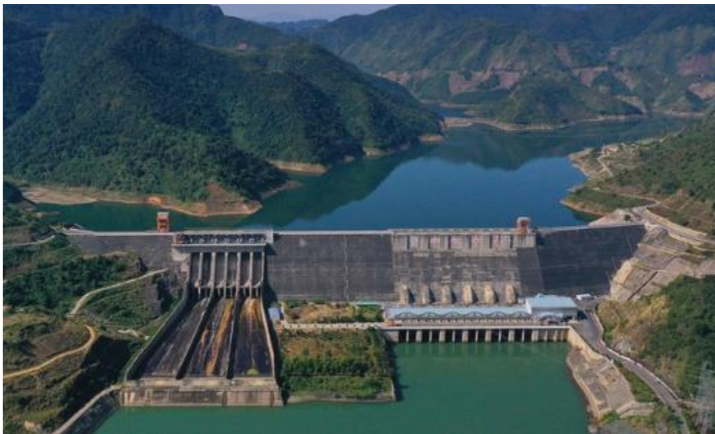
Hình 2. Nhà máy thủy điện
