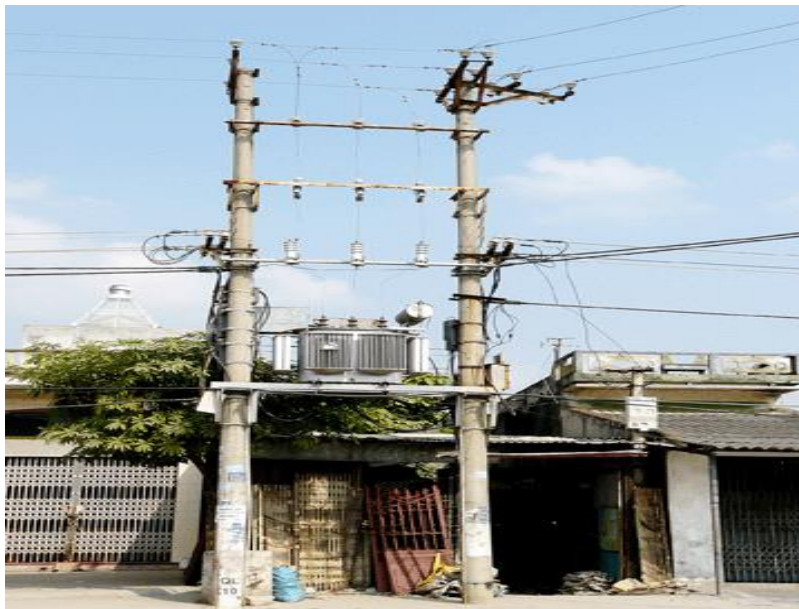
Hình 2-9: Trạm treo S_{dm} \leq 3 \times 75 kVA
