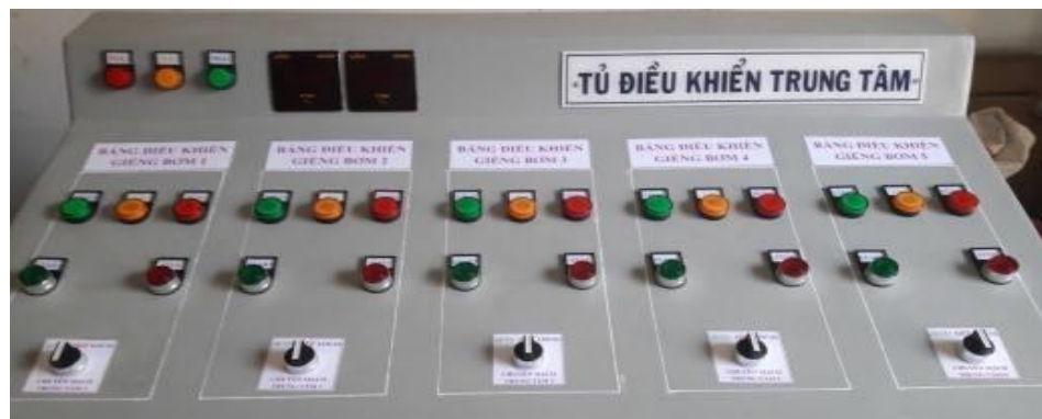
Hình 2.2: Tủ điện điều khiển trung tâm
