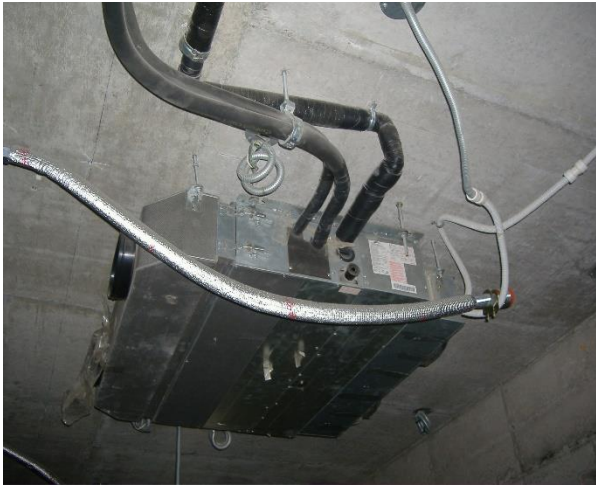
Các FCU vừa lắp xong
