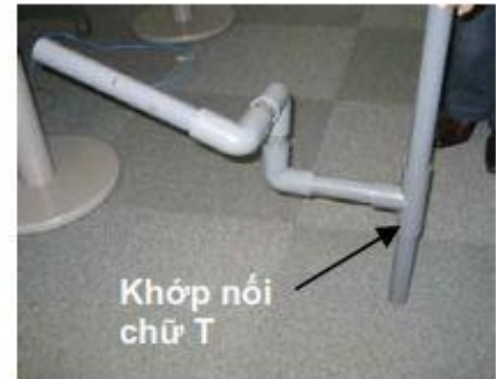
Nối với ống xả dọc bằng khớp nối chữ T
