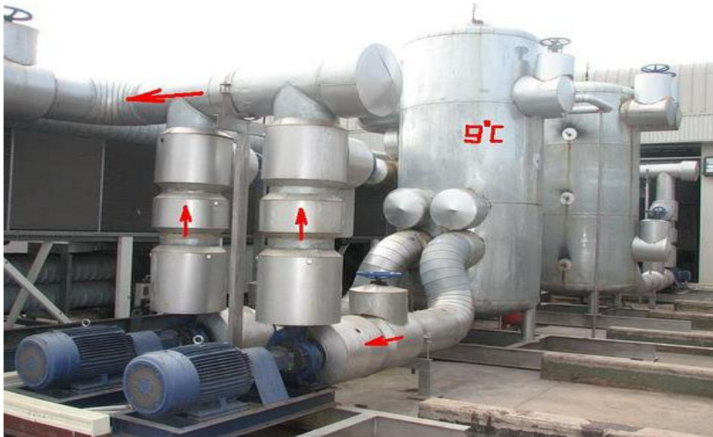
Hình 1.14: Đường ống nước lắp đặt được bóc cách nhiệt.
