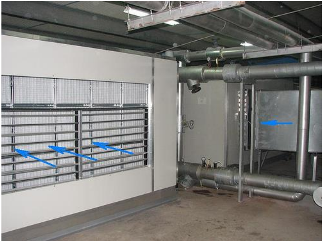
Khi được lắp ống dẫn khí vào
