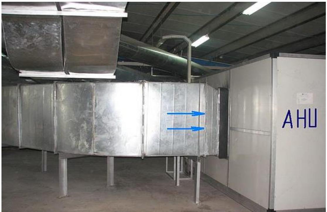
Cửa ra của không khí sạch và lạnh được đẩy đi nhờ vào cái quạt màu xanh.
