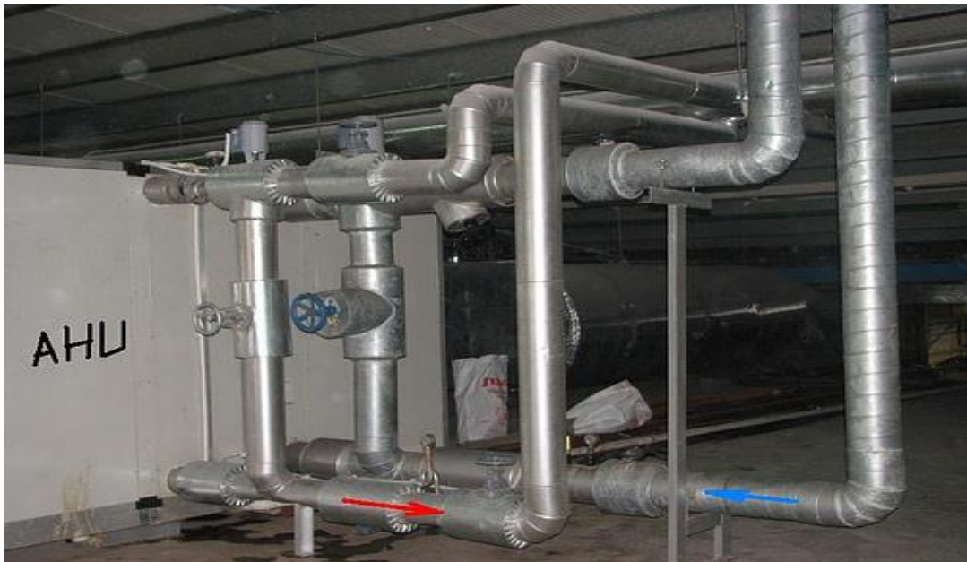
Nơi không khí vào AHU, không khí được lọc nhờ vào những tấm màng màu trắng.
