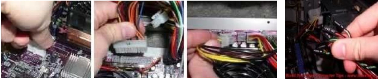
Hình 1.17: Lắp các đầu dây vào main
