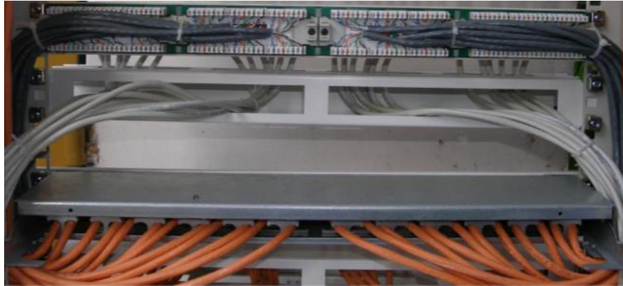
Hình 7.4 lắp đặt cáp Patchpanel
