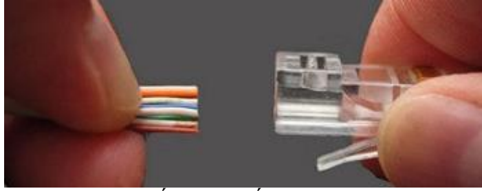
Hình 7.11 Tiến hành bấm dây mạng bước 5
