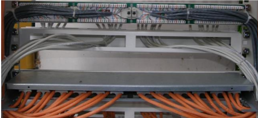
Hình 7.4 lắp đặt cáp Patchpanel
