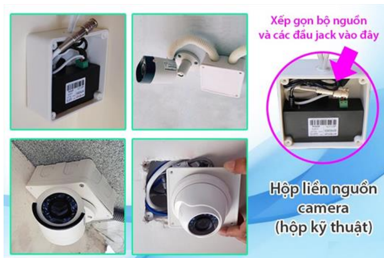
Hình 2.38 Cách lắp đặt hộp nguồn kỹ thuật (hộp liền nguồn) cho camera
