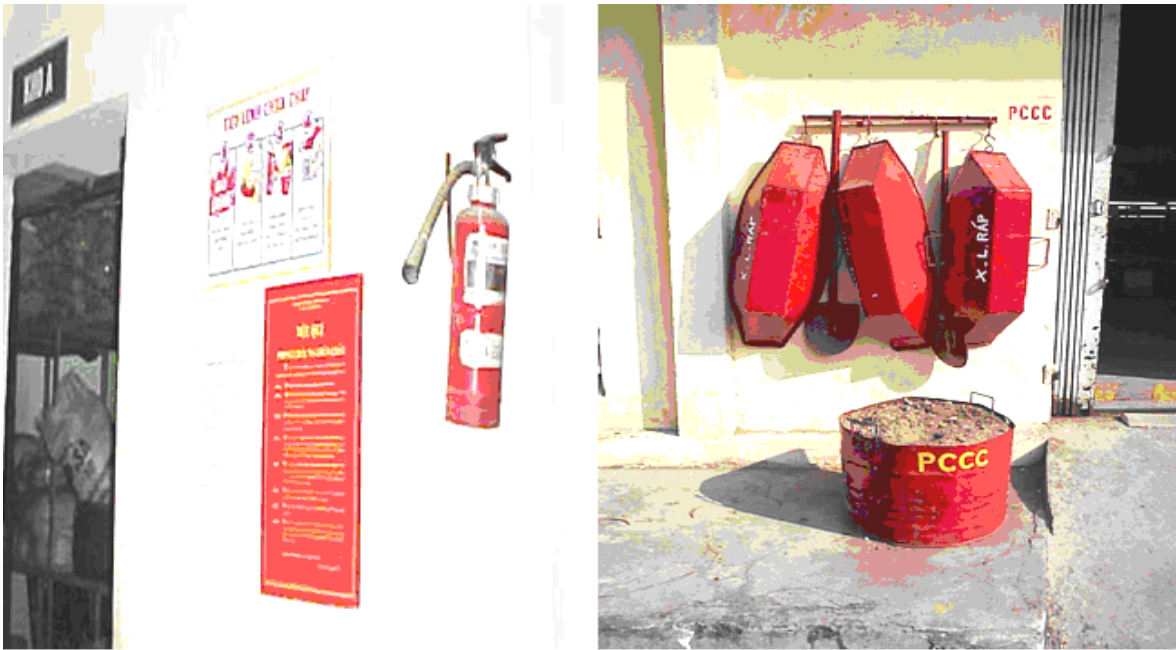
(a) (b) Hình 2.3: a. Bảng quy định về trình tự PCCC b. Dụng cụ thô sơ phụ vụ PCCC
