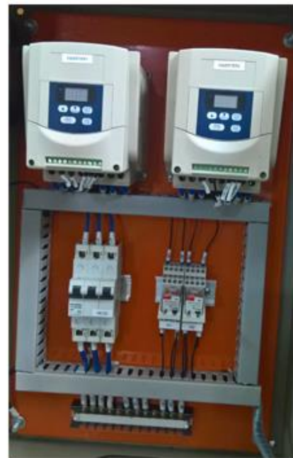
Hình 6.2.1: Bàn phím cài đặt của một loại biến tần 1 pha.
