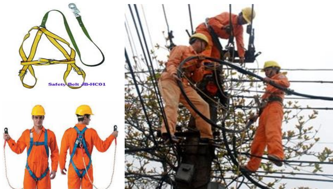
Hình 2.1: Dây đai an toàn
