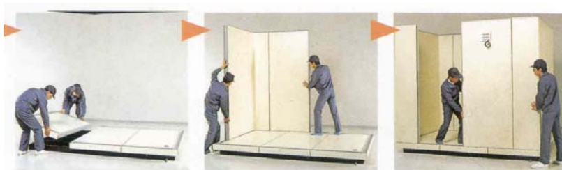
Hình 2-4: Lắp ghép panel kho lạnh
