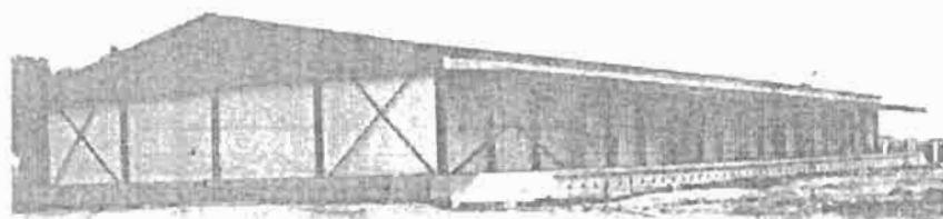
Hình 2-17. Hình dáng một kho lạnh lắp ghép 1000 tấn với kết cấu khung thép chịu lực và mái tôn
