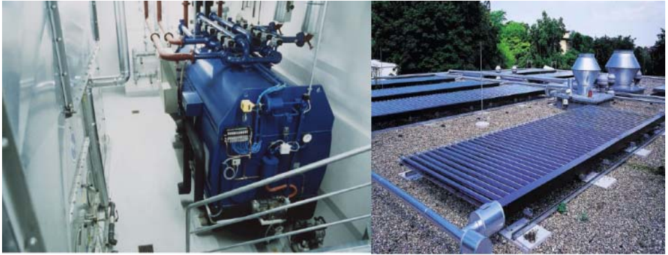
Hình 4.120. Máy lạnh hấp thụ sử dụng năng lượng mặt trời
