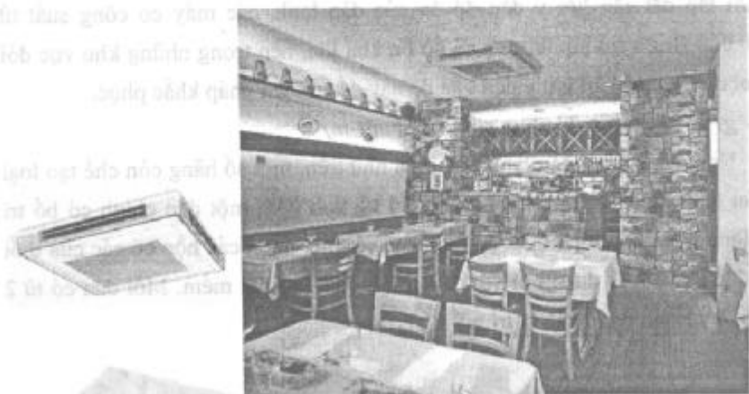
Hình 6.9. Dàn lạnh cassette treo dưới trần và cách lắp đặt
